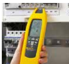
Auffinden von Sicherungen und Sicherungsautomaten und Zuordnung zu Stromkreisen
